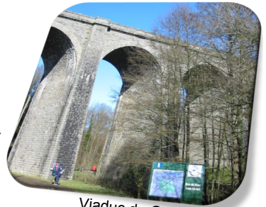
Viaduc du Guibel
